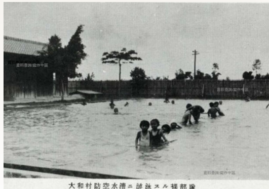
圖 11 大和村消防池，夏天作為泳池
