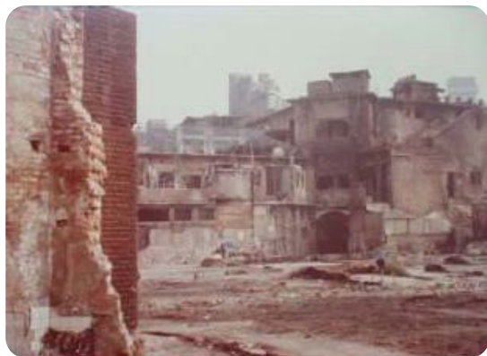
圖 17 火災後第一市場狀況 (許欽鐘提供)
